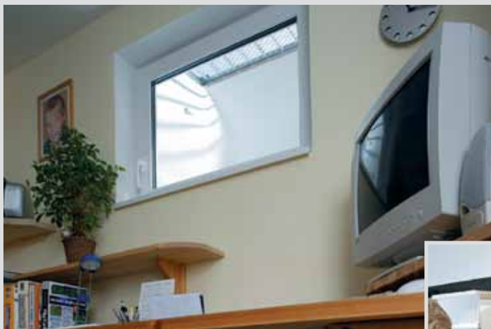
Pivničné svetlíky (anglické dvorce) a plastové okná
